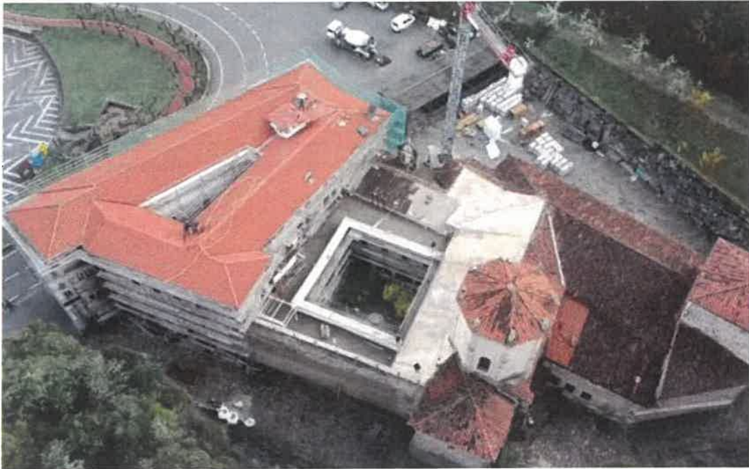
Obras realizadas en el monasterio de Santo Toribio
